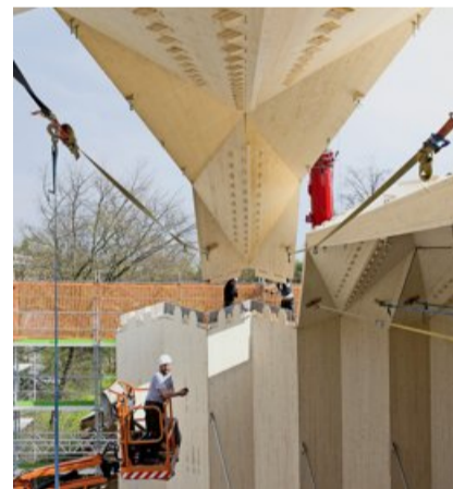
Onze arches ont été assemblées sur site, mais 17 des 18 étapes de fabrication ont été menées en usine.
